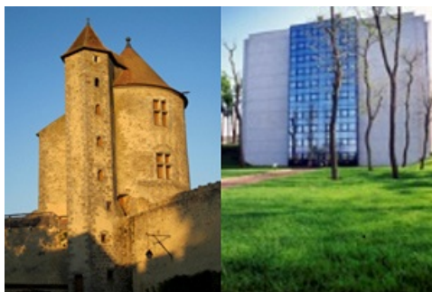
La tour des Archives du château de Blandy (©) et la tour de conservation des Archives départementales de Seine-et-Marne
