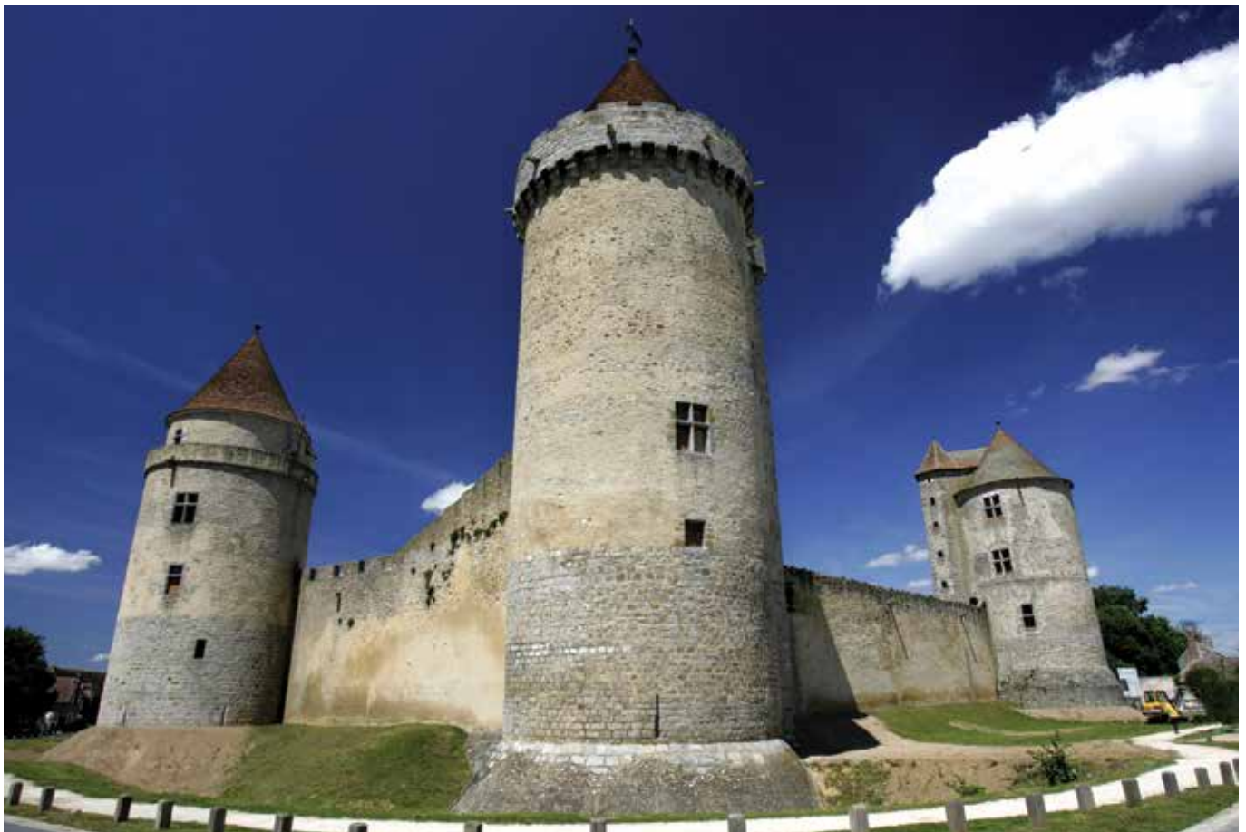
Vue de la tour des archives, du donjon et de la tour des gardes. © Département de Seine-et-Marne, Patrick Loison.
